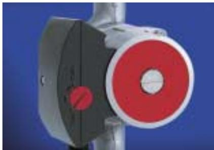
Schalten Sie die Umwälzpumpe zu Beginn der Heizsaison ein und kontrollieren Sie, ob die Pumpe auf einer möglichst niedrigen Stufe läuft. Ist die Pumpe auf eine höhere Stufe eingestellt, schalten Sie sie zurück und prüfen Sie, ob die Heizkörper trotzdem warm werden. Falls nicht, schalten Sie die Pumpe wieder um eine Stufe höher.
